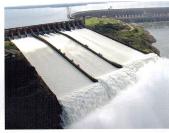
6. Ressaut hydraulique en bas d'un déversoir à proximité du barrage d'Itaipu (frontière Brésil-Paraguay). L'eau s'écoule très rapidement sur le plan incliné avant que l'épaisseur de la couche liquide n'augmente brusquement. Cette transition est ici déclenchée par une légère remontée du plan incliné.
